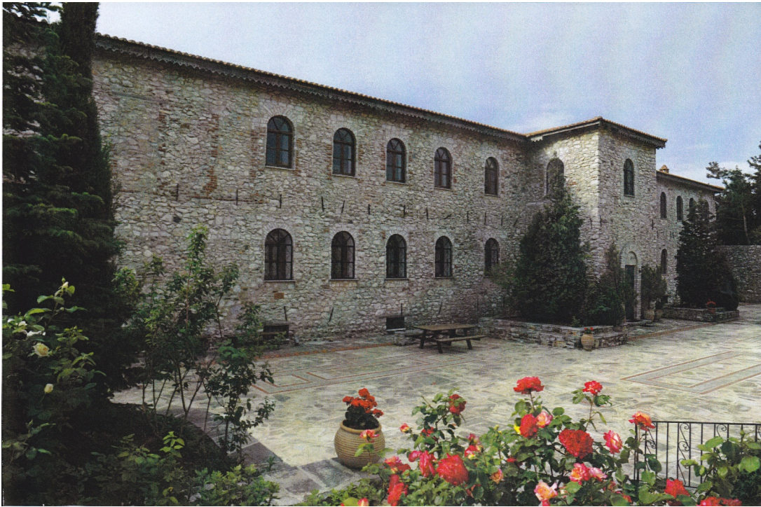
Εικόνα 3: Όψη της Μονής(εσωτερικά από τον αύλειο χώρο) μετά την ανακατασκευή
