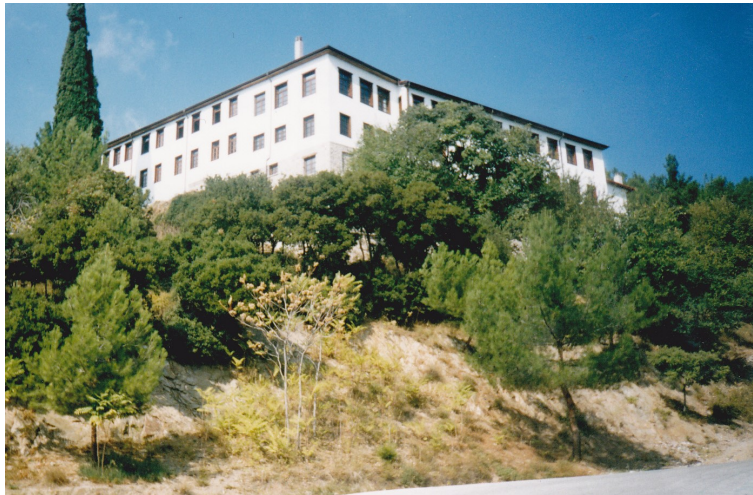
Εικόνα 28: Αποψη της Μονής μετά την ανακατασκευή από το δρόμο.
