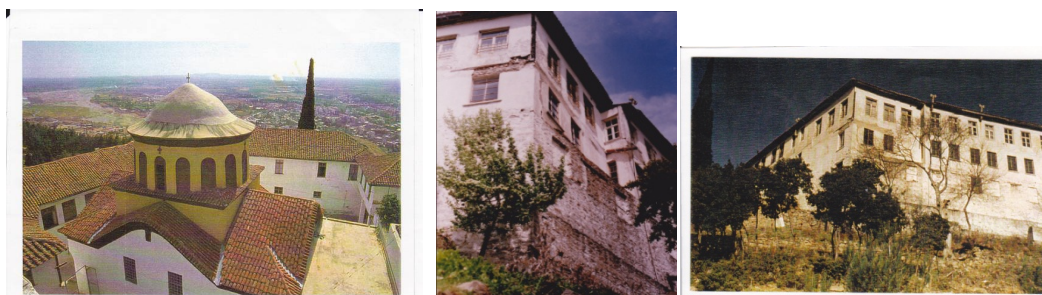
Εικόνα 6: Άποψη της Ι.Μ. από την αυλή Εικόνες 7,8: Εξωτερικές όψεις του κτιρίου
