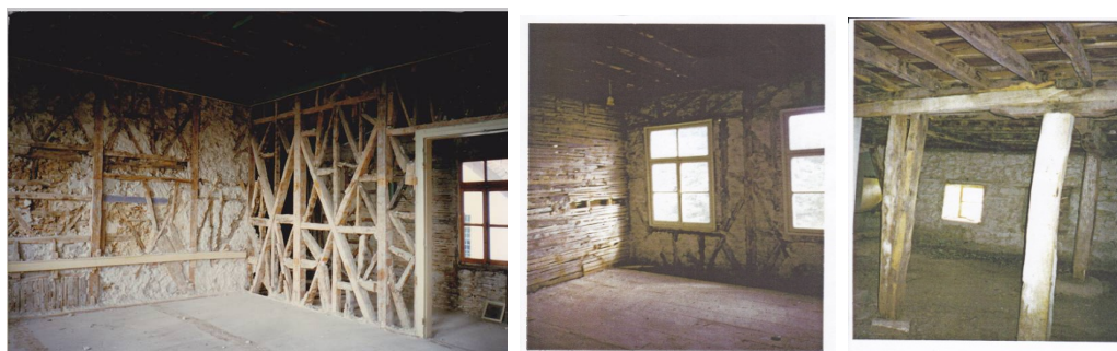
Εικόνες 9,10,11: Φωτογραφική αποτύπωση από το εσωτερικό του κτιρίου
